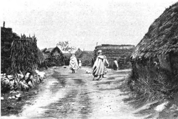
FIG. 73. — Le village nègre de Mazagan en 1901 (Cliché de l'auteur)
