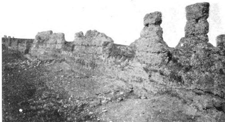
FIG. 41. — Ruines de l'enceinte d'El Mdîna (l'iché de l'auteur)
